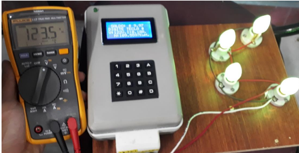
Fig. 67 Luminarias sin interruptor conectadas al medidor.
