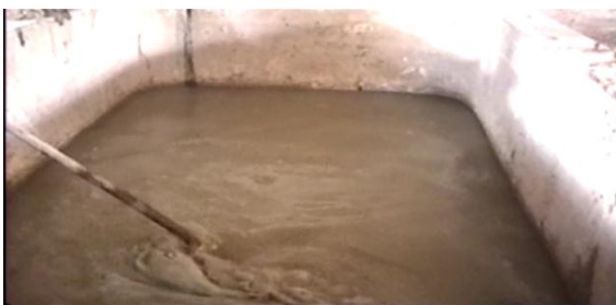
Imagen N° 3 tanque de calero
