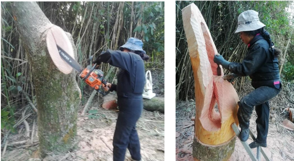
Figura 20. Inicio de la primera obra desbaste
