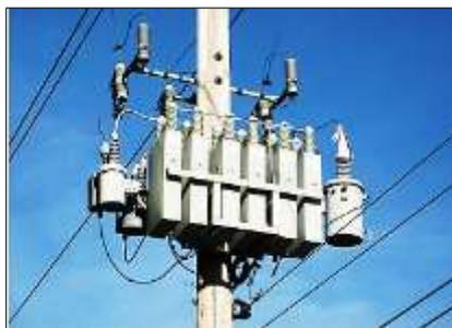
Fig. 3. Bancos de capacitores para media tensión.
