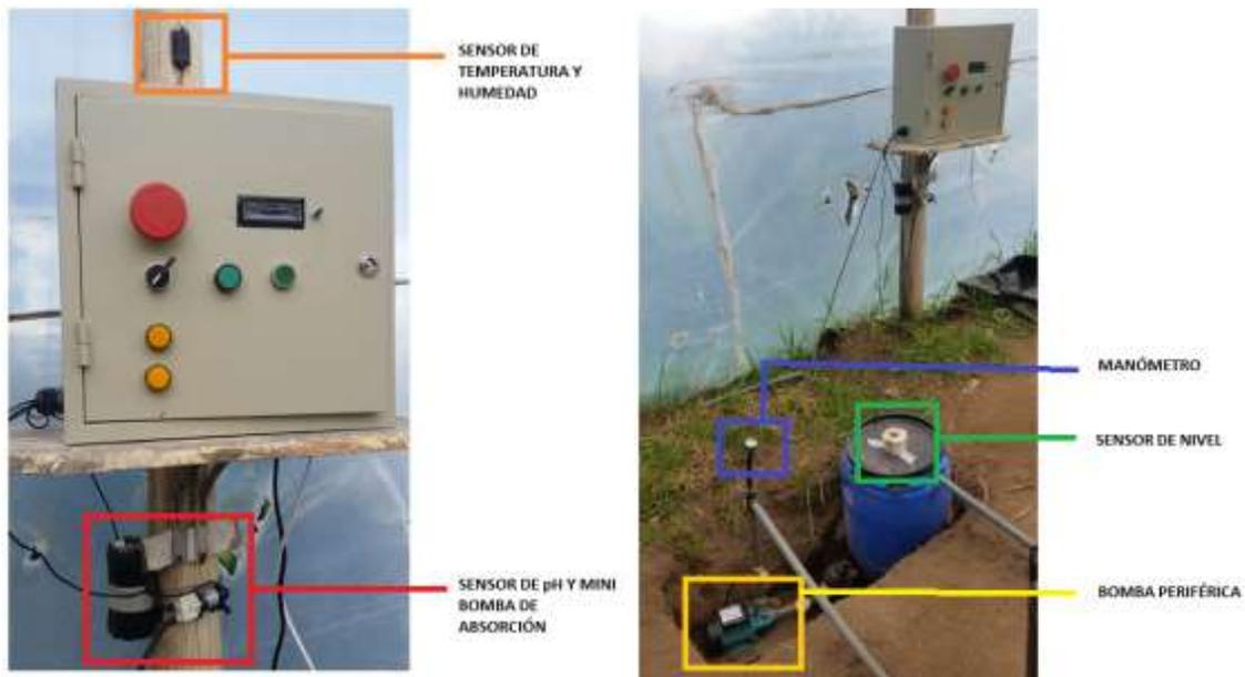
Fig. 3.8 Elementos de control instalados en el invernadero
