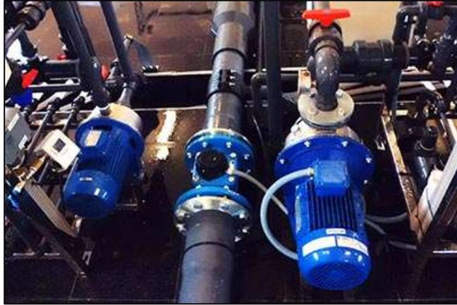
Fig. 1.6 Bomba de riego.
