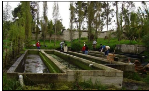
Foto 3.8. Retiro de lodos de las estanques
