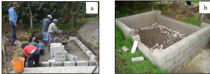
Foto 3.5 Fases de construcción de tanque de lodos sistema uno. a) Cimentación del tanque, b) Elaboración del filtro.
