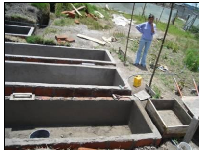
Foto 3.20. Construcción de sistemas unifamiliares
