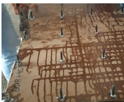
Figura 3.14. Sellado de los tableros
