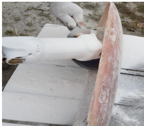
Figura 3.25. Pulido de la pieza
