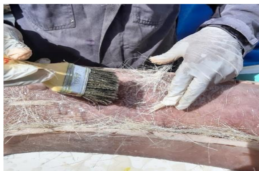
Figura 3.22. Aplicación de la fibra de cabuya
