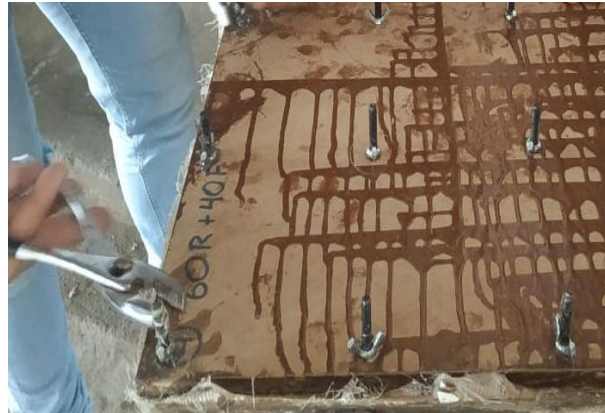
Figura 3.16. Sellado de los tableros
