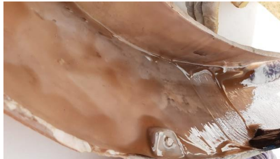
Figura 3.21. Aplicación de la resina poliéster
