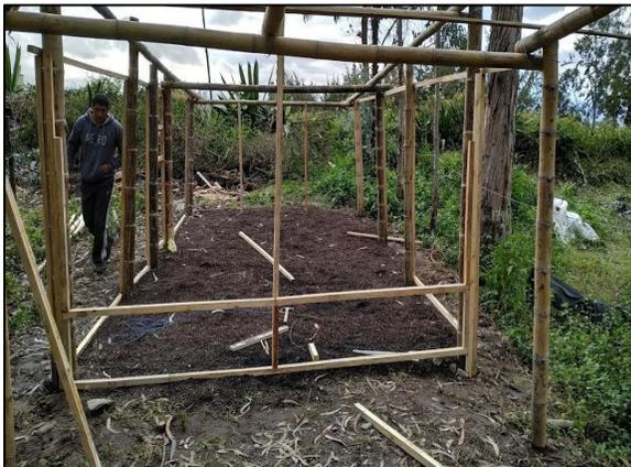
*Construcción de estructura para la cámara solar*
