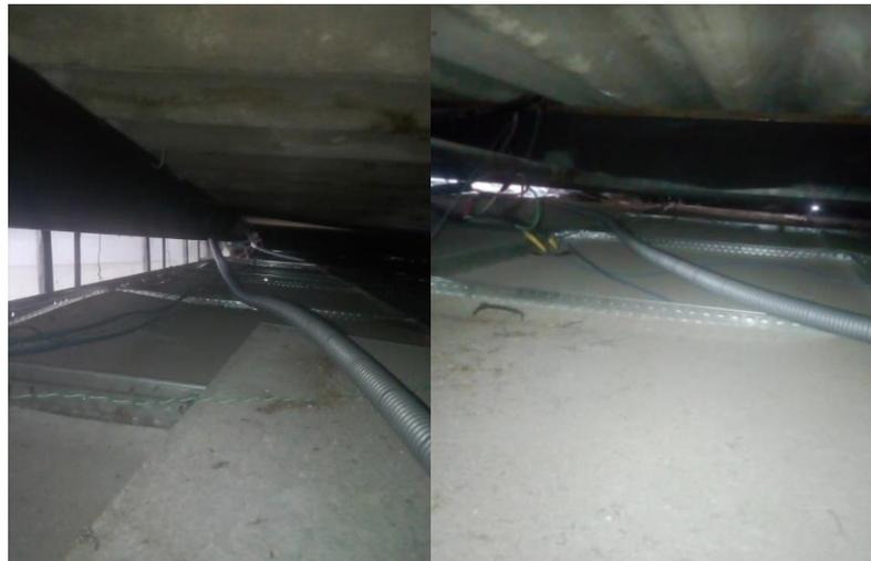
Fig. 3.1. Canalización con manguera corrugada
