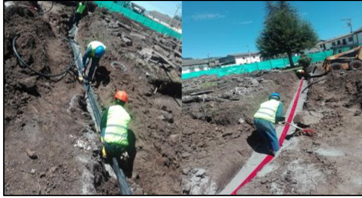
Fig. 1 Tendido de ductos de la red subterránea. Fuente: (ELECTRIC, 2019).
