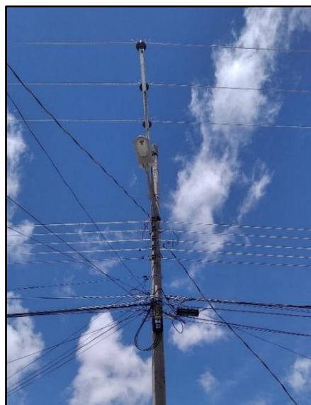
Fig. 13 Red de bajo voltaje. Fuente: (EMELNORTE, 2019).
