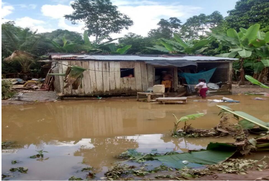
Figura 15. Vivienda de 2 de ambientes inundada
