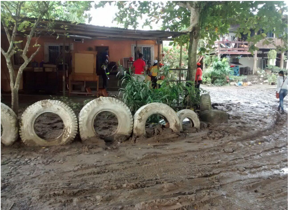
Figura 17. Vías de acceso deterioradas por la etapa invernal.
