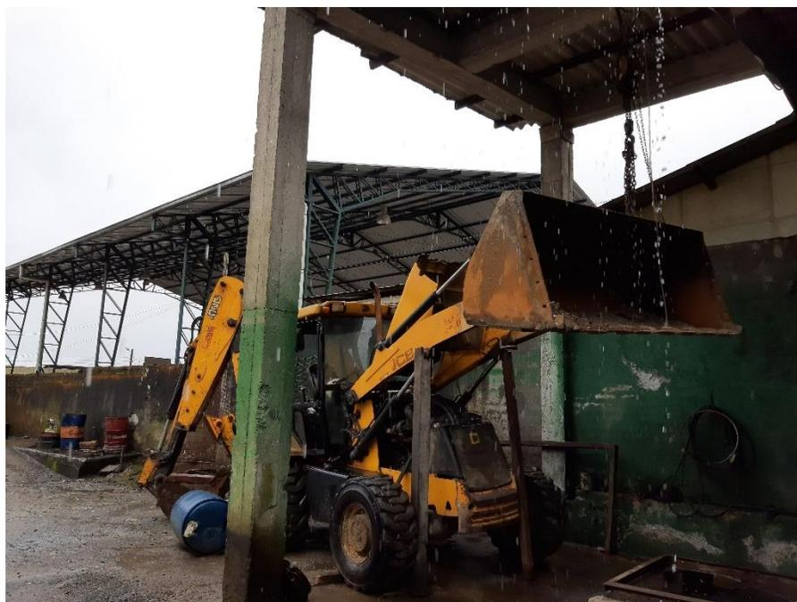
**Figura A.I.5** Techos en malas condiciones
