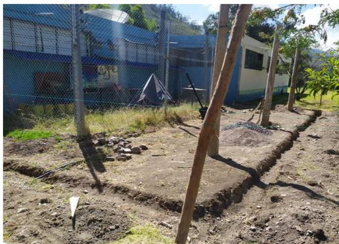
**Figura 2.8** Excavación de la zanja
