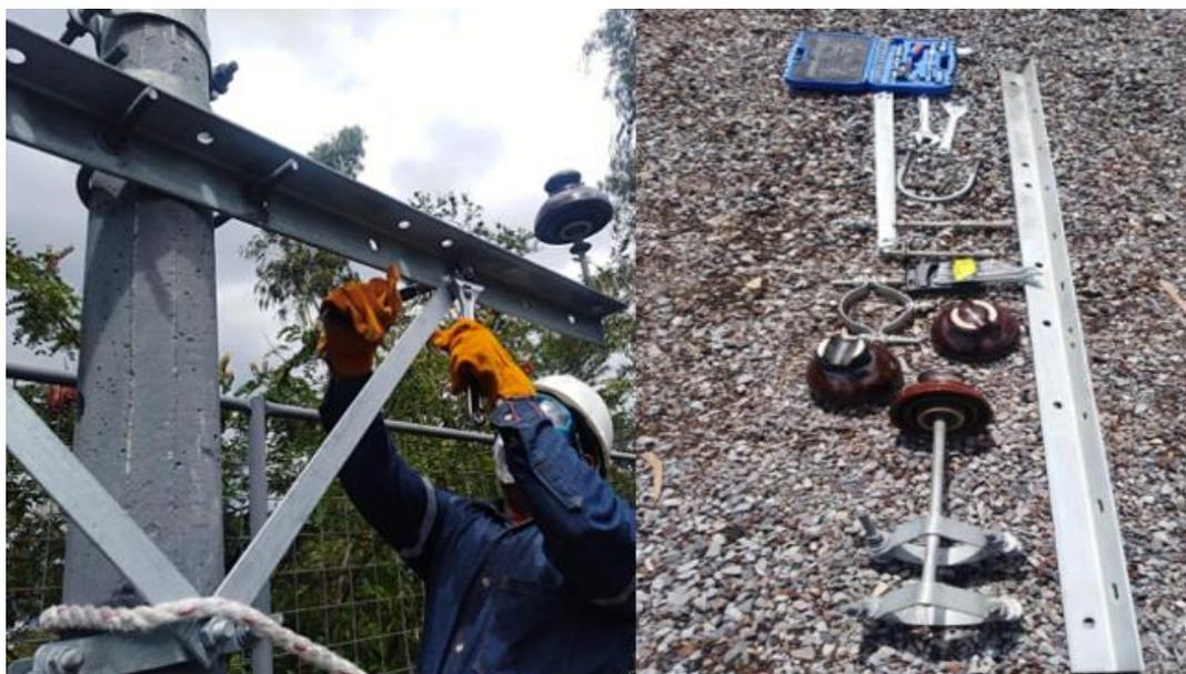
**Figura 3.1** Montaje estructura centrada pasante
