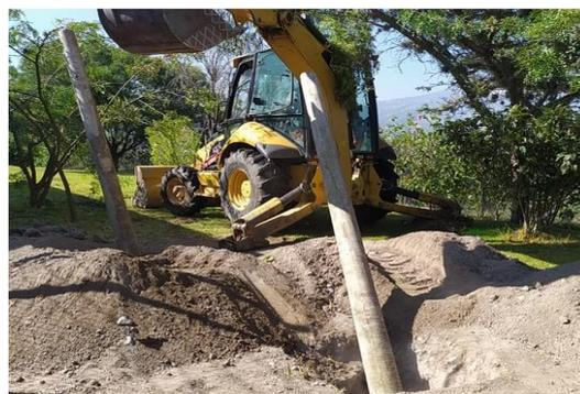
**Figura 2.5** Movilización de postes de hormigón
