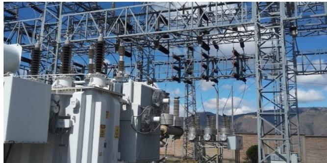
**Figura 1.2** Subestación de distribución
