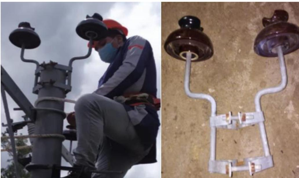
**Figura 3.4** Montaje estructura monofásica centrada angular
