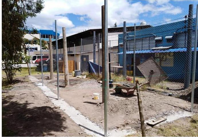
**Figura 2.10** Fundición de los tubos para el cerramiento
