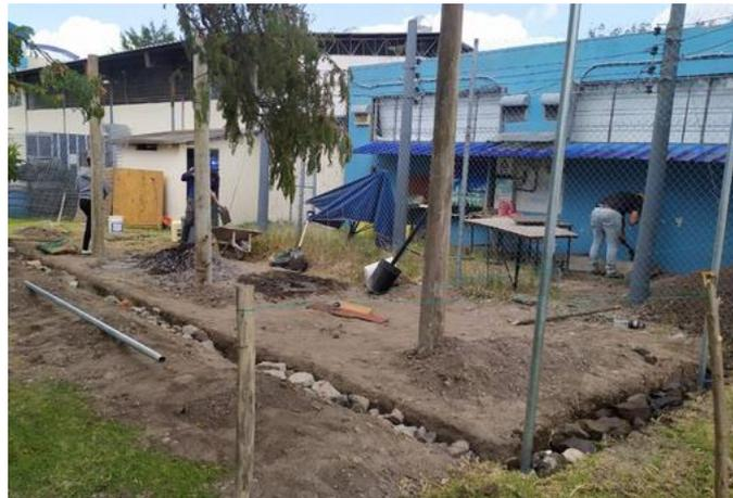
**Figura 2.9** Empedrado e implementación de tubos del cerramiento
