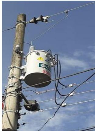
**Figura 1.4** Transformador de Distribución monofásico
