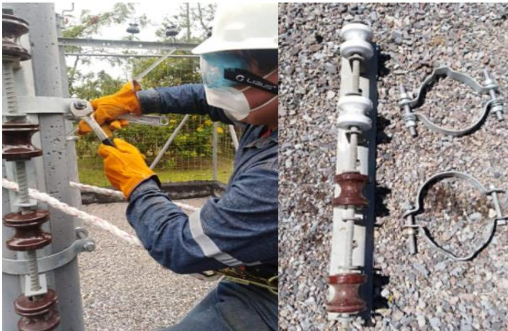
**Figura 3.5** Montaje estructura de bajo voltaje rack de cuatro vías
