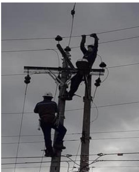
**Figura 1.33** Montaje de estructuras de media tensión
