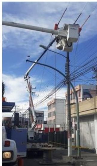
**Figura 1.34** Equipos para trabajos con tensión (línea viva)
