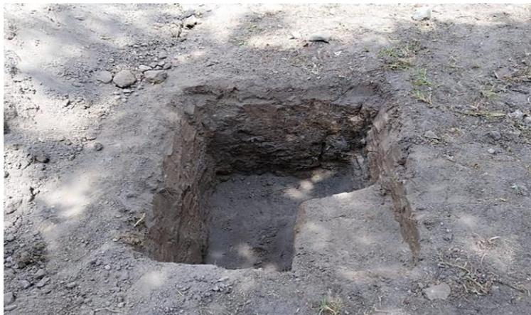
**Figura 2.3** Excavación para la cimentación del poste de hormigón
