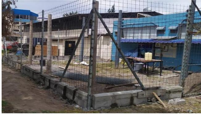
**Figura 2.12** Realización del bordillo del cerramiento
