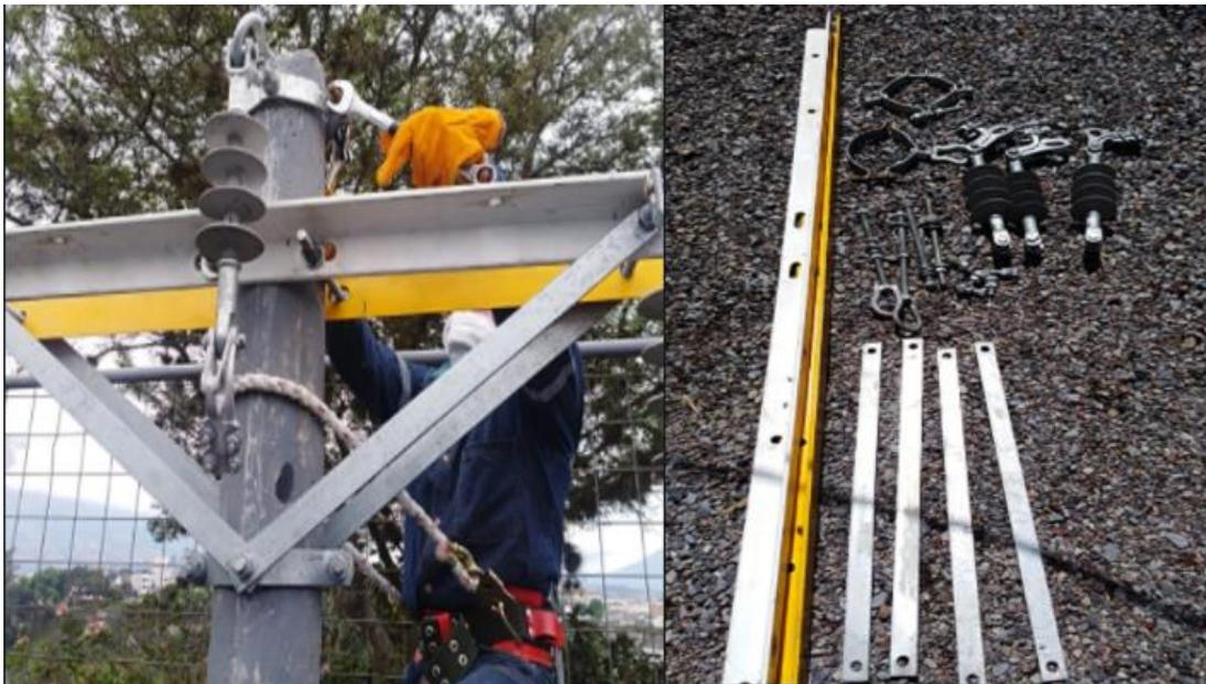
**Figura 3.2** Montaje estructura centrada retenida
