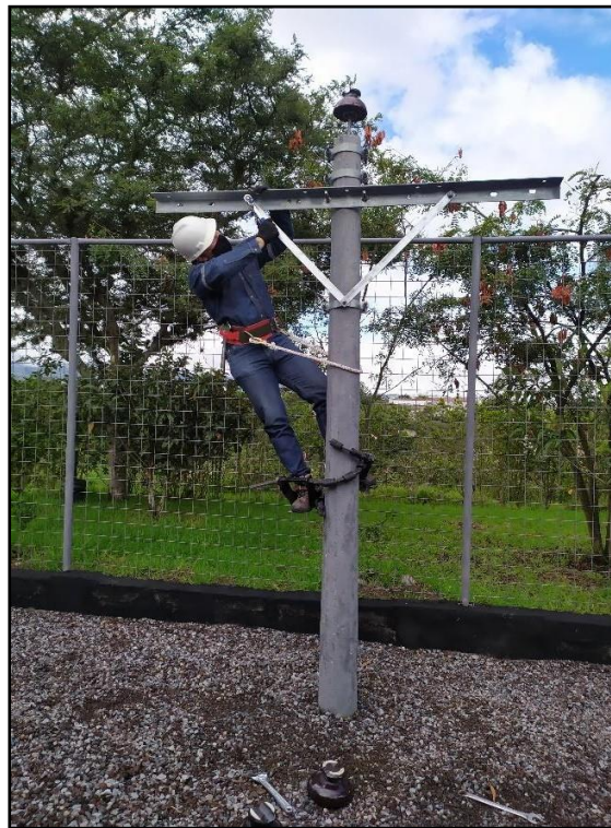
Fig. 3.5 Subida al poste con trepadoras para montar el seccionador. Fuente: Autor.
