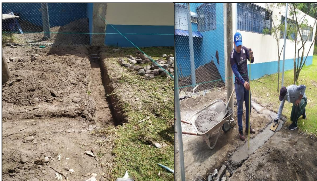
Fig. 2.9 Zanja para el cerramiento.
