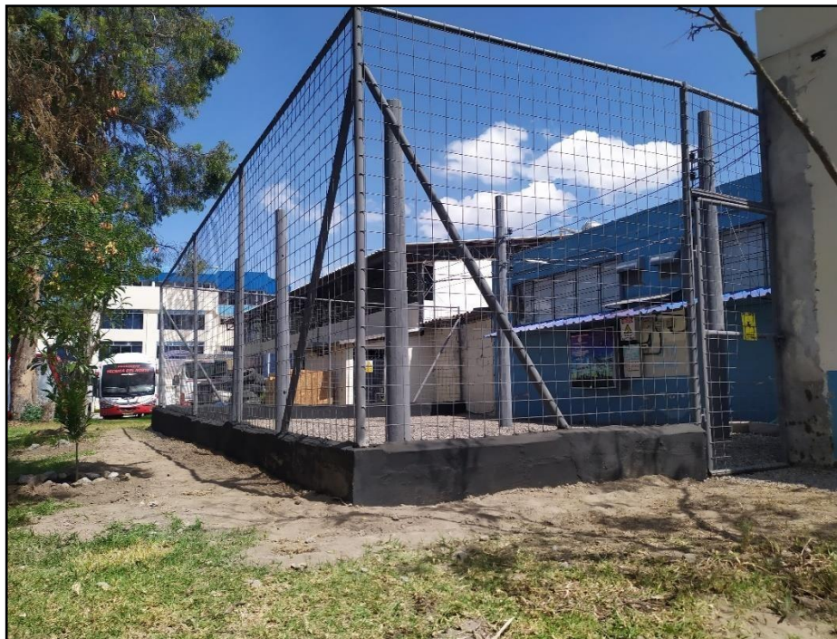
Fig. 2.16 Patio de pruebas.
