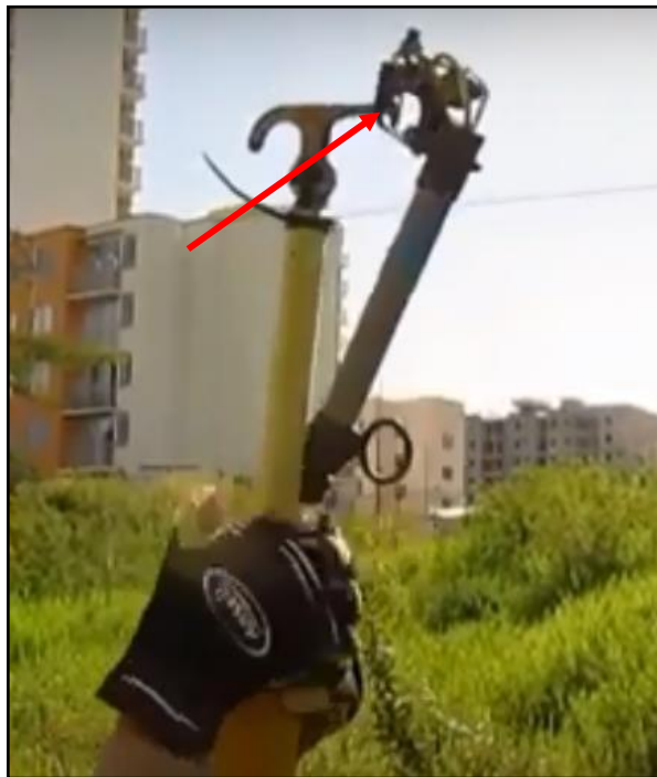
Fig. 3.9 Enganche del portafusible con la pértiga. Fuente: Autor.
