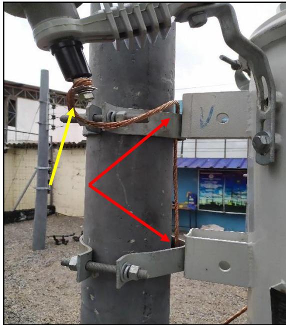
Fig. 3.17 Recorrido de conductor para la puesta a tierra. Fuente: Autor.
