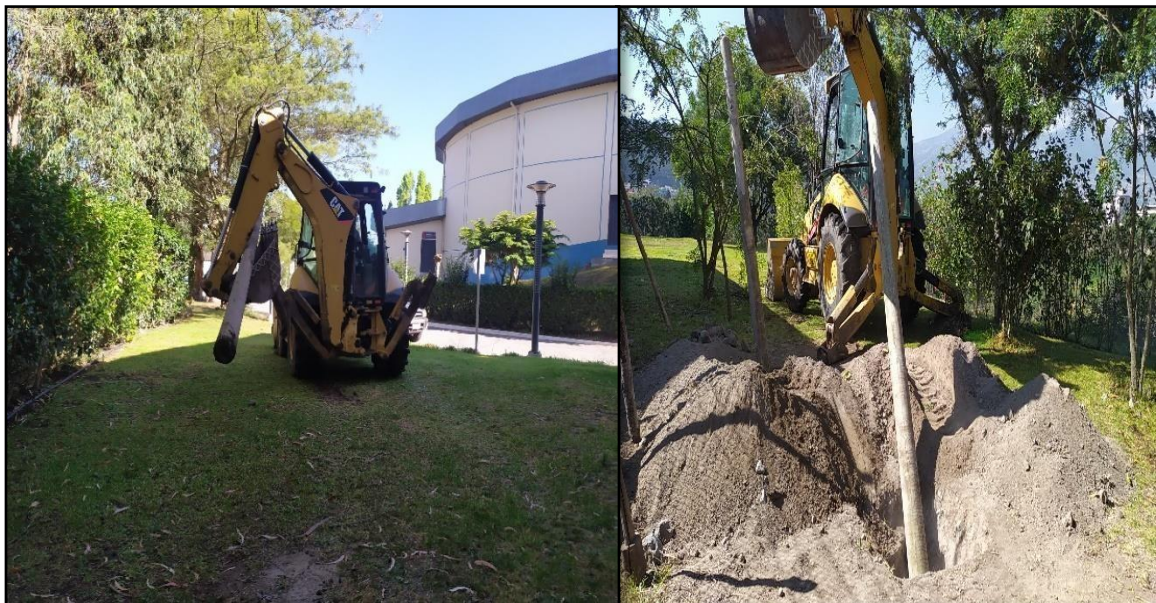
Fig. 2.6 Transporte de los postes de hormigón.
