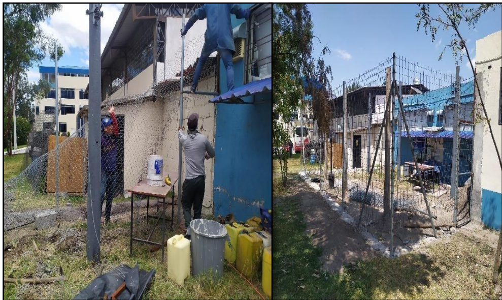
Fig. 2.11 Retirada y colocación de la malla.
