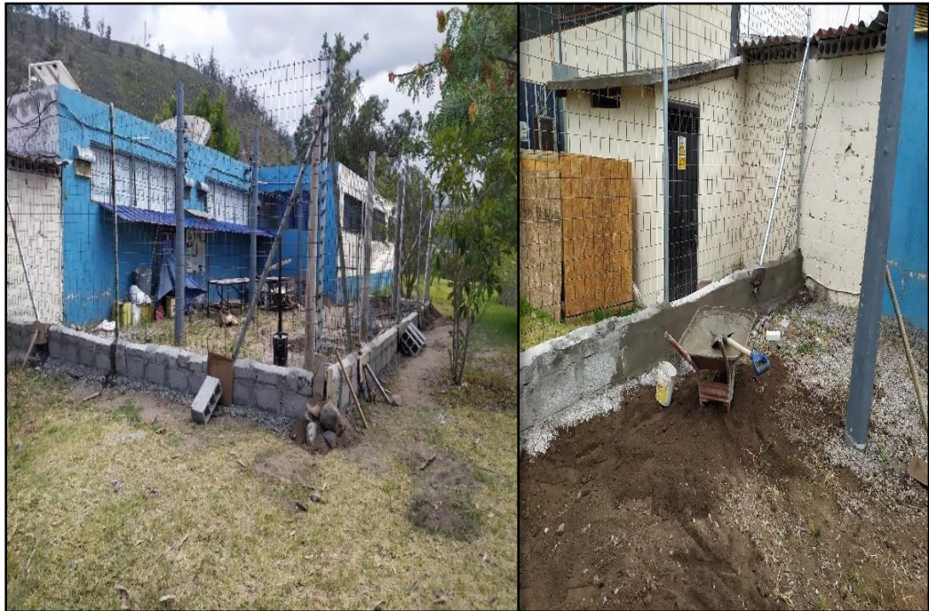
Fig. 2.12 Construcción y enlucido del muro.
