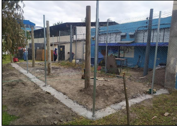
Fig. 2.10 Cimiento de la zanja y tubos fijados.
