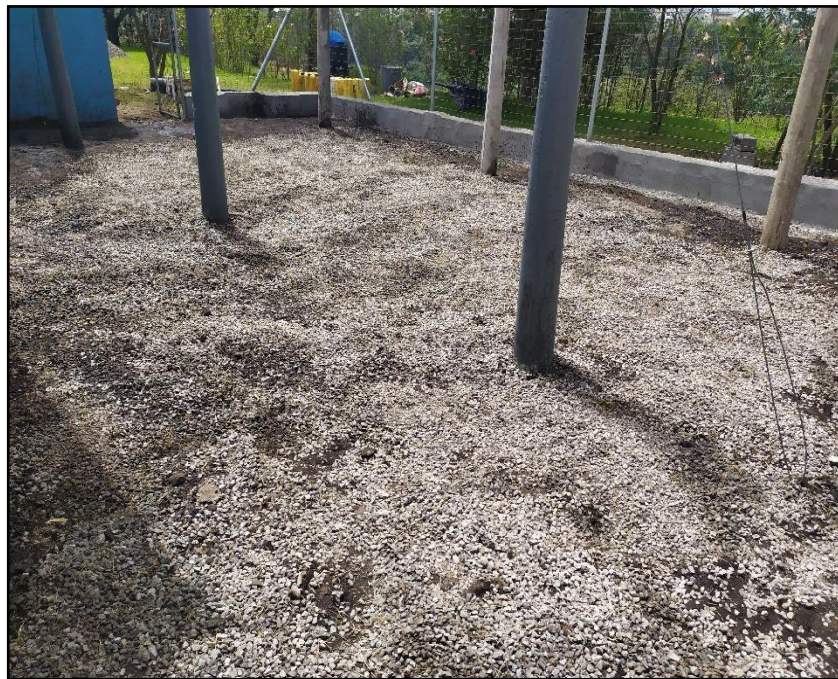
Fig. 2.14 Colocación de la chispa.
