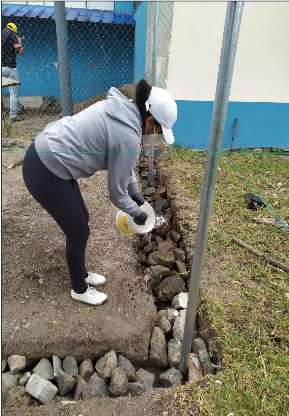
Fig. B.4 Cimiento para el cerramiento del patio de pruebas. Fuente: Autor.
