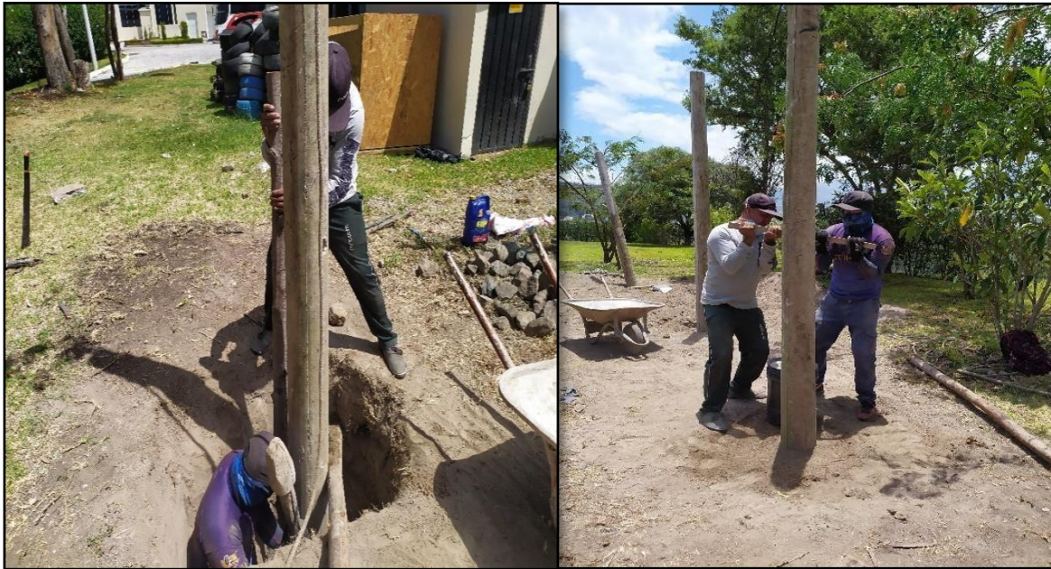
Fig. 2.7 Fijación de los postes de hormigón. Fuente: Autor.
