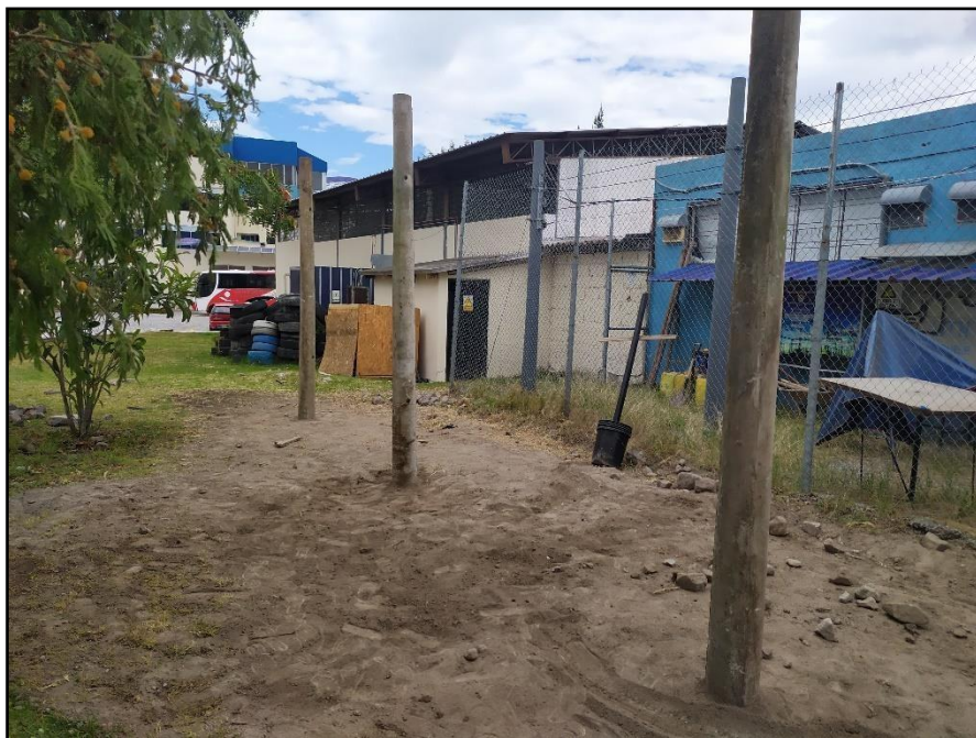
Fig. 2.8 Parada de los postes de hormigón. Fuente: Autor.
