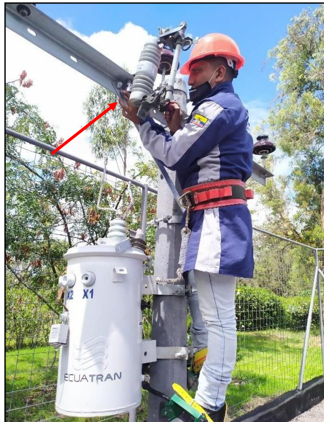
Fig. 3.7 Ajuste de la tuerca para el montaje del seccionador. Fuente: Autor.
