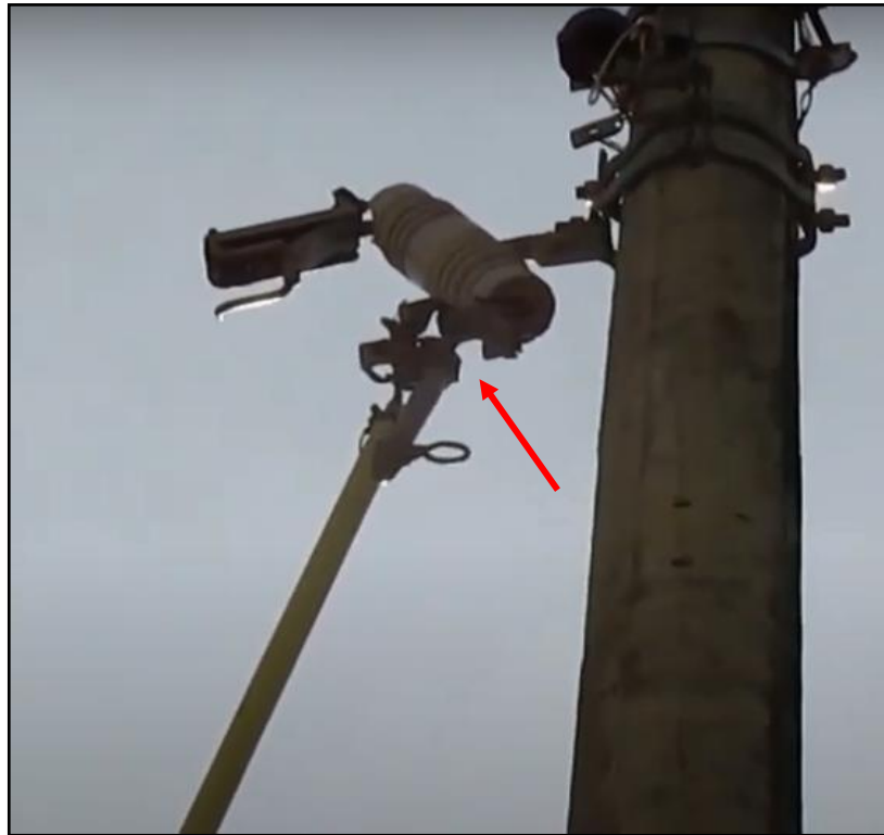
Fig. 3.10 Montaje en la parte inferior. Fuente: Autor.
