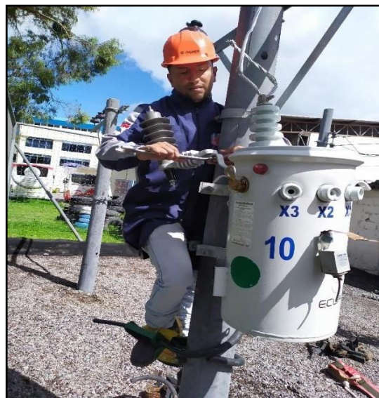
Fig. 3.3 Ajuste de la tuerca para el montaje del pararrayo. Fuente: Autor.
