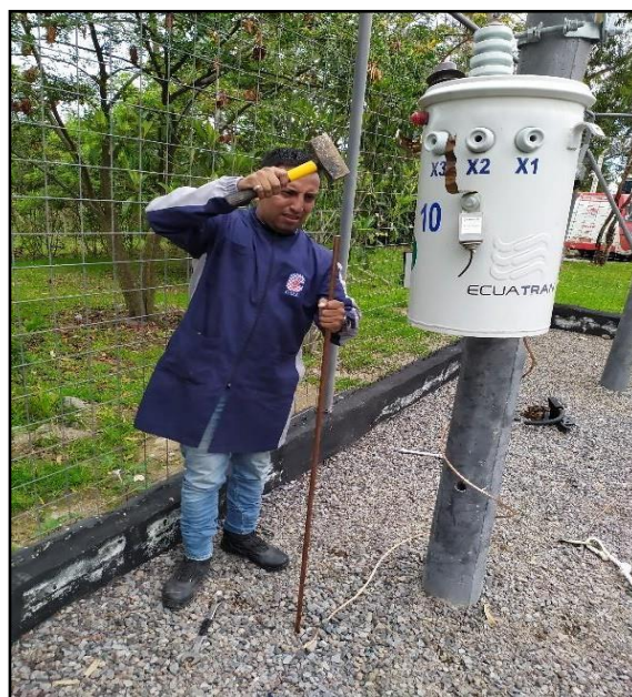
Fig. 3.19 Enterrado de la varilla de puesta a tierra. Fuente: Autor.
