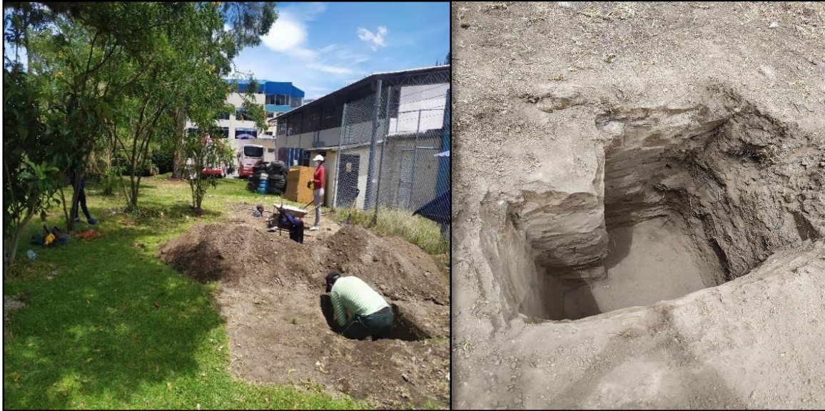
Fig. 2.5 Excavación y resultado de los huecos para los postes de hormigón.
