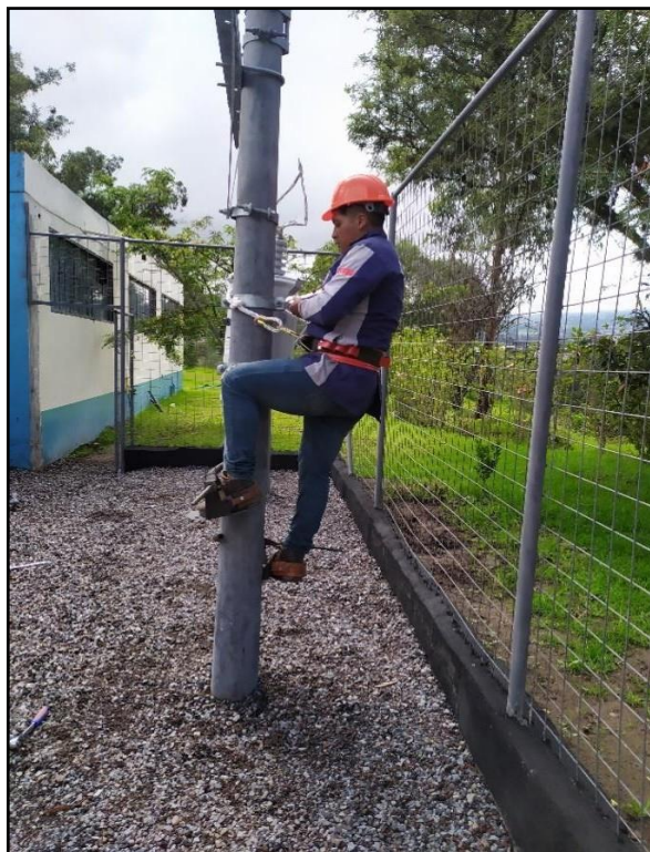
Fig. 3.1 Subida al poste con trepadoras para colocar el pararrayo. Fuente: Autor.
