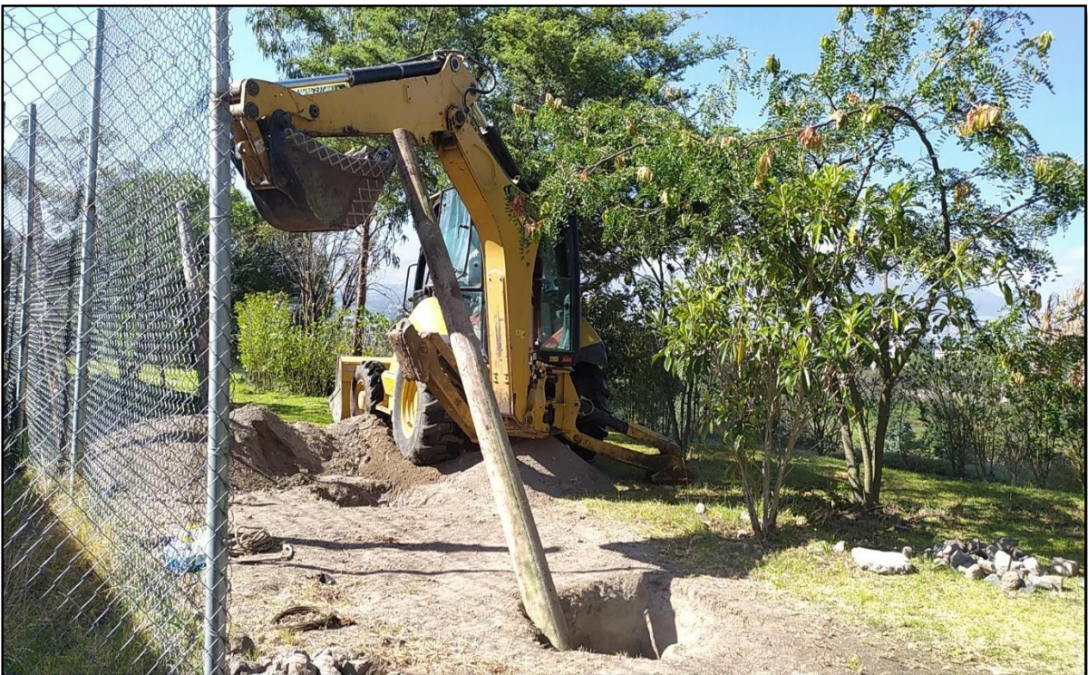
Fig. B.2 Llevado de los postes de hormigón armado con la retroexcavadora. Fuente: Autor.
