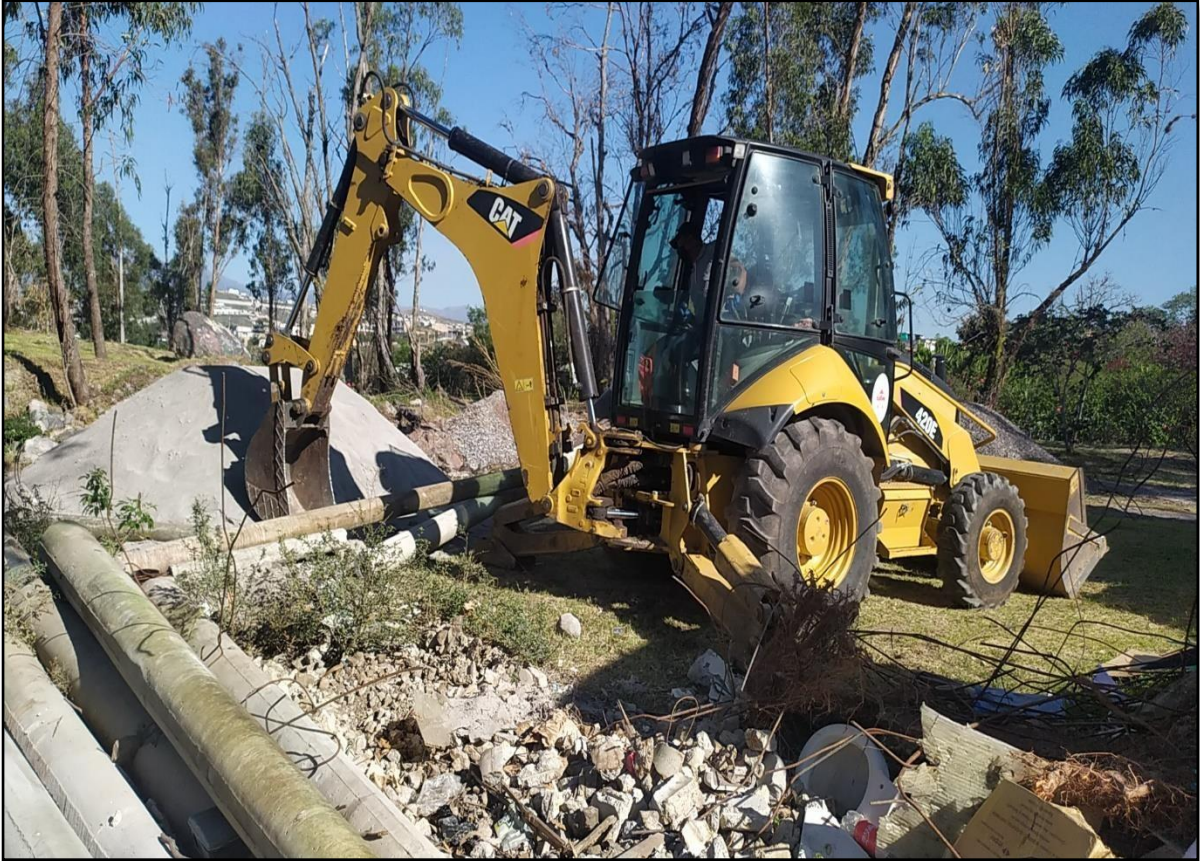
Fig. B.2 Llevado de los postes de hormigón armado con la retroexcavadora. Fuente: Autor.
