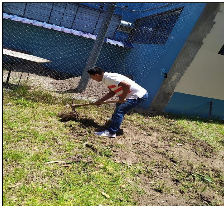
Fig. 2.4 Limpieza del terreno.
