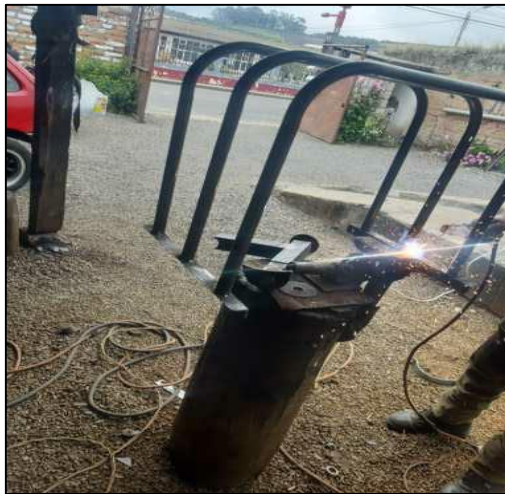
Figura 3.5 Corte del tubo para la rejilla Fuente: (Autores)
