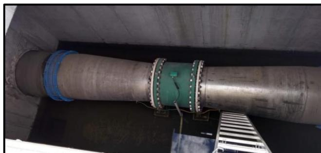
Fig. 2.4 Salida de descarga desde el tubo Venturi
