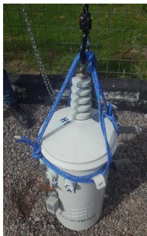
Figura 6. Colocación del cabo en el transformador.
