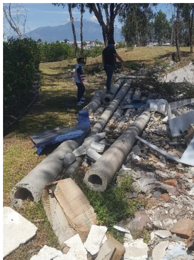
Fig. 24. Adecuación de los postes a una altura apropiada.
