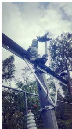
Figura 14. Ensamblado del porta fusible.
