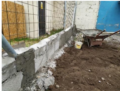
Fig. 34. Construcción del muro.
