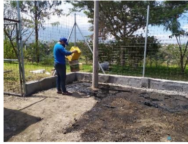
Fig. 35. Roseado de aceite quemado en el espacio del patio.
