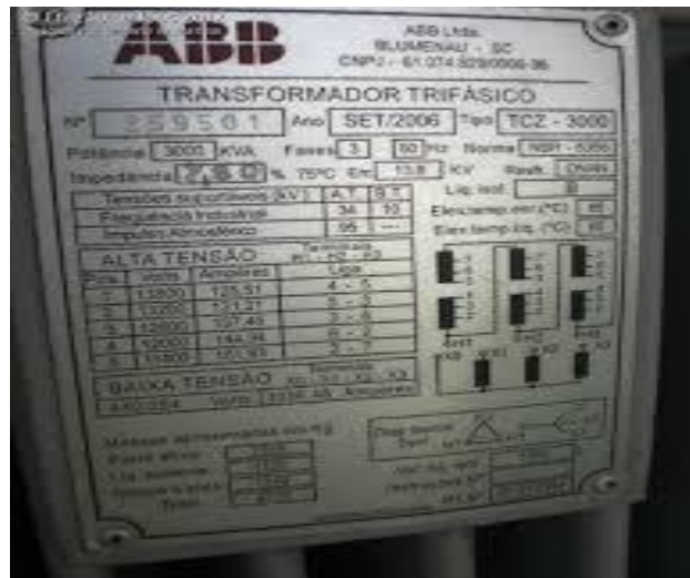
Fig. 3. Datos de placa de un transformador trifásico.
