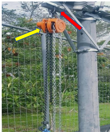
Fig. 41. Montaje de la estructura acoplada al tecele.
