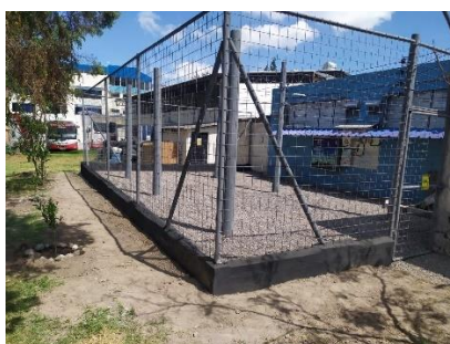
Fig. 37. Resultado del Emulador de patio, para el montaje de un transformador tipo poste.
