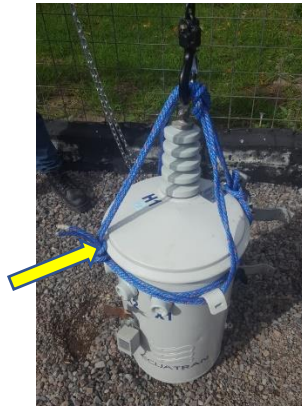
Fig. 42.- Centrado del transformador para el acenso.
