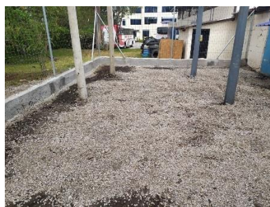
Fig. 36. Colocación del ripio en el espacio del patio.
