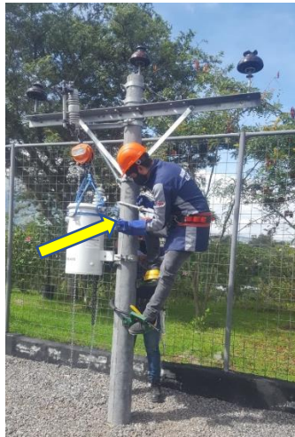
Fig. 44.- Ensamblado del transformador.
