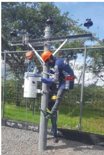
Figura 8. Ensamblado del transformador.
