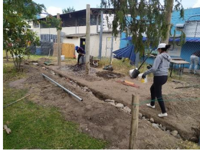
Figura 31. Cimentación del muro.
