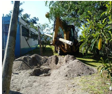
Figura 25. Movilización de los postes.
