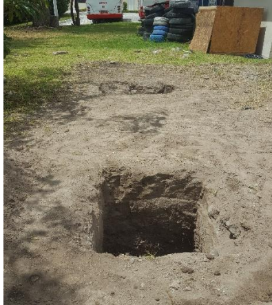
Fig. 23.- Excavación para la colocación de los postes.
