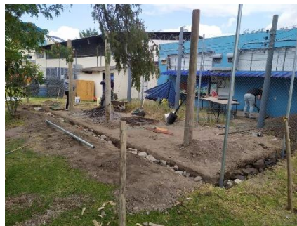
Fig. 32. Colocación de los tubos de acero galvanizado.
