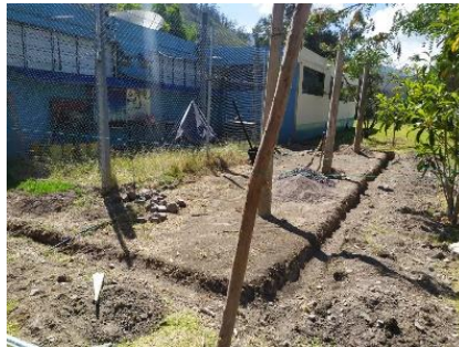
Fig. 27. Excavación de la zanja para el cerramiento.
