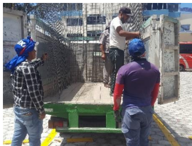
Fig. 28. Adquisición de la malla presoldada.
