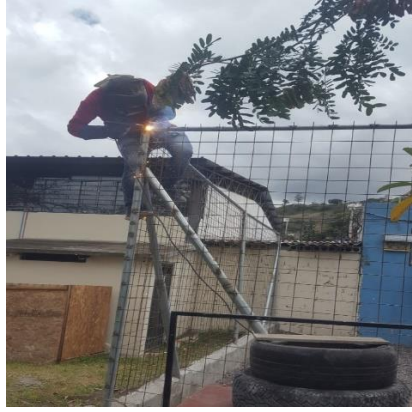
Fig. 33. Colocación de la malla.
