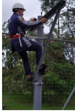
Figura 13. Colocación de la cruceta.
