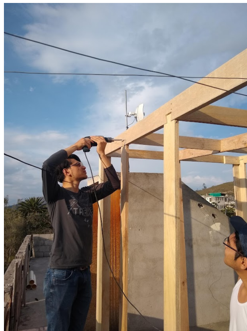
Figura 4.4: Construcción del invernadero.
