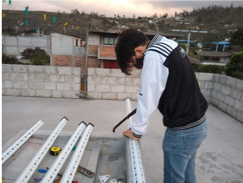
Figura 4.3: Corte a medida deseada del perfil L ranurado.
