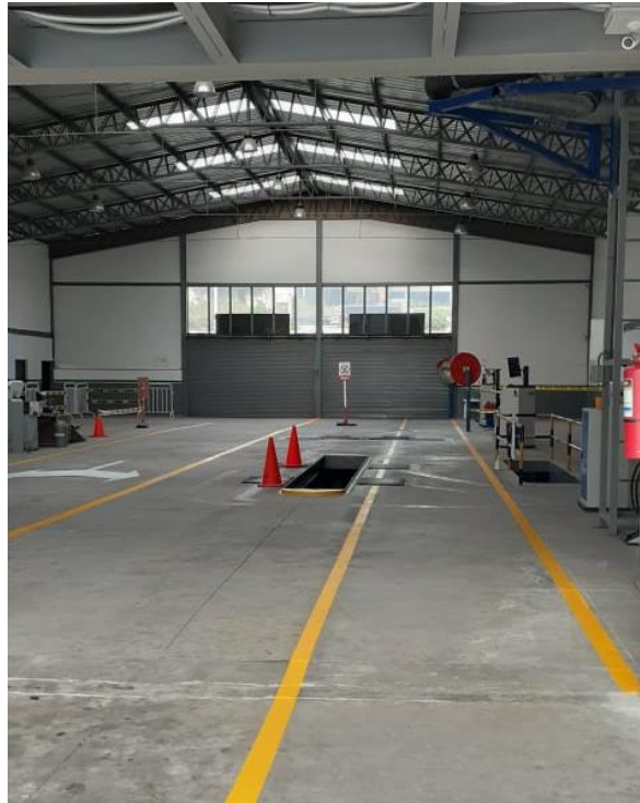
Fotografía 3. Señalización finalizada área RTV
