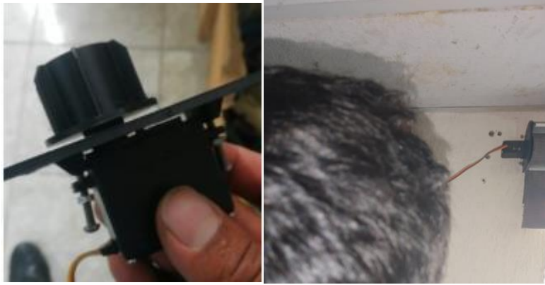
Fig. 66. Instalación de servo motor en persiana. Fuente: Elaborado por el autor
