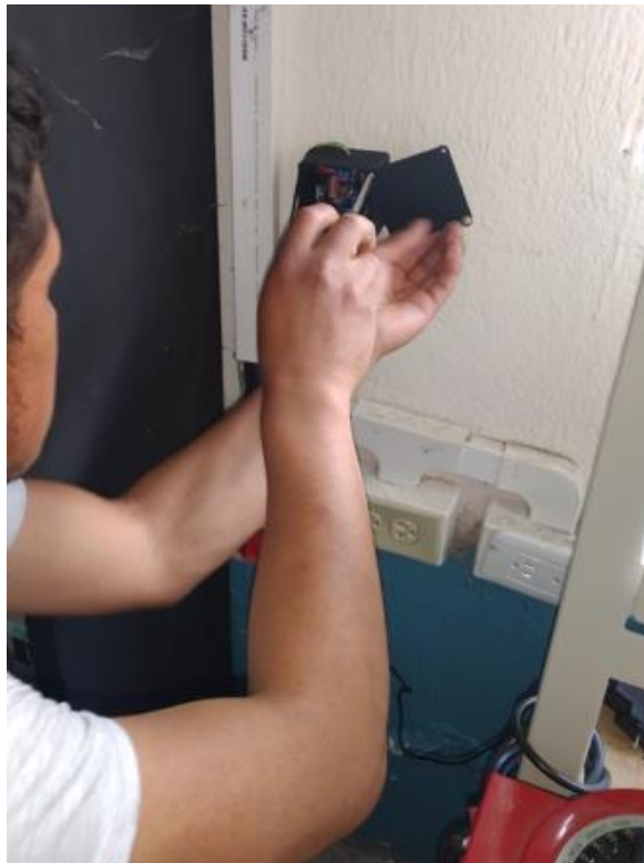
Fig. 67. Instalación de servo motor en persiana. Fuente: Elaborado por el autor
