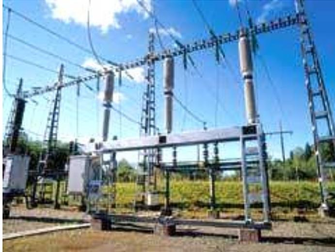
Fig. 1.10. Interruptores en una subestación eléctrica
