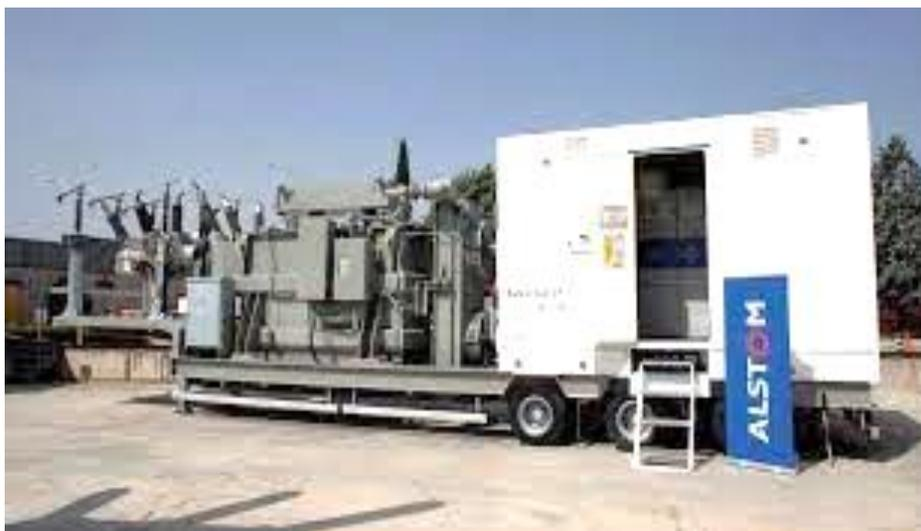
Fig. 1.5. Subestación Móvil.
