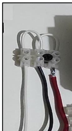
Figura 3. Barra de alimentación negativa Fuente: Autor
