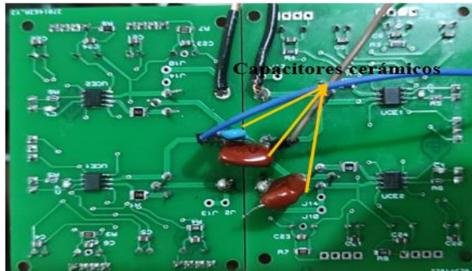
Figura 36. Montaje capacitores cerámicos para mejorar calidad de onda Fuente: Autor
