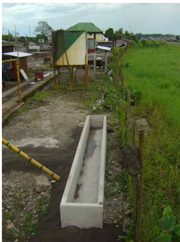
Figura 7.2.10. Jardinera construida para la evacuación de lodos tratados
