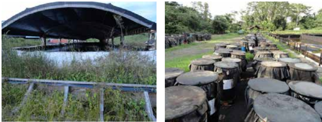
Figura 4.28. Almacenamiento de residuos. A) Piscina y B) tanques de almacenamiento de residuos líquidos aceitosos
