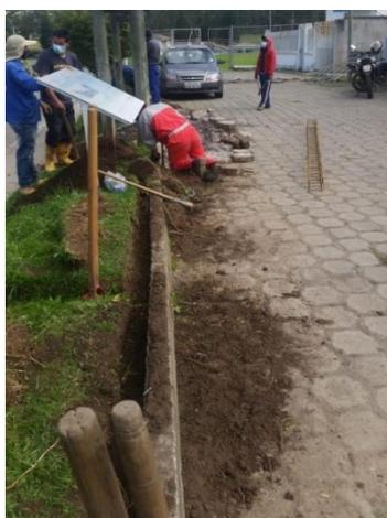
Para la conexión de los paneles en serie se utiliza los conectores MC4 de los mismos módulos, para la conexión en paralelo se utiliza dos conectores MC4 de 3 a 1 con un cable 10 AWG, por factores ambientales se soterró todas las líneas de transmisión hasta el gabinete.
