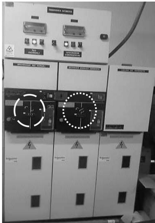
Fig.31. Tablero de transferencia.
