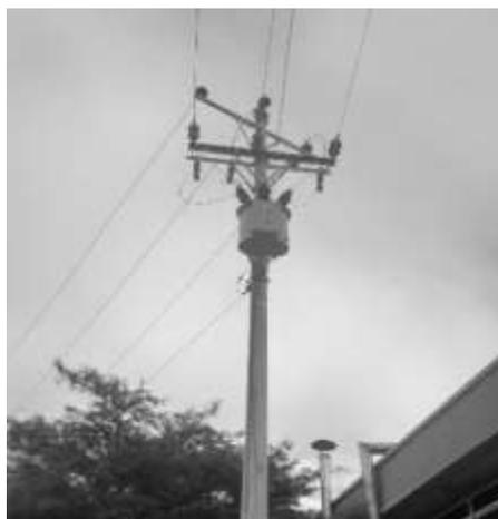
Fig.22. Transformador combinado de medición.
