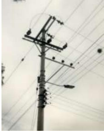
Fig.25. Estructura aérea de medio y bajo voltaje.
