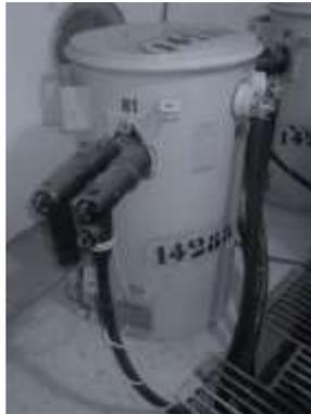
Fig.13. Transformador con frente muerto. Fuente: (MEER, 2020)
