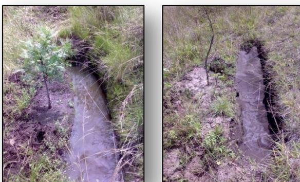
**Fotografía 19 y 20.** Zanjas de infiltración reteniendo humedad y sedimentos. Yahuarcocha, UTN, 2007
