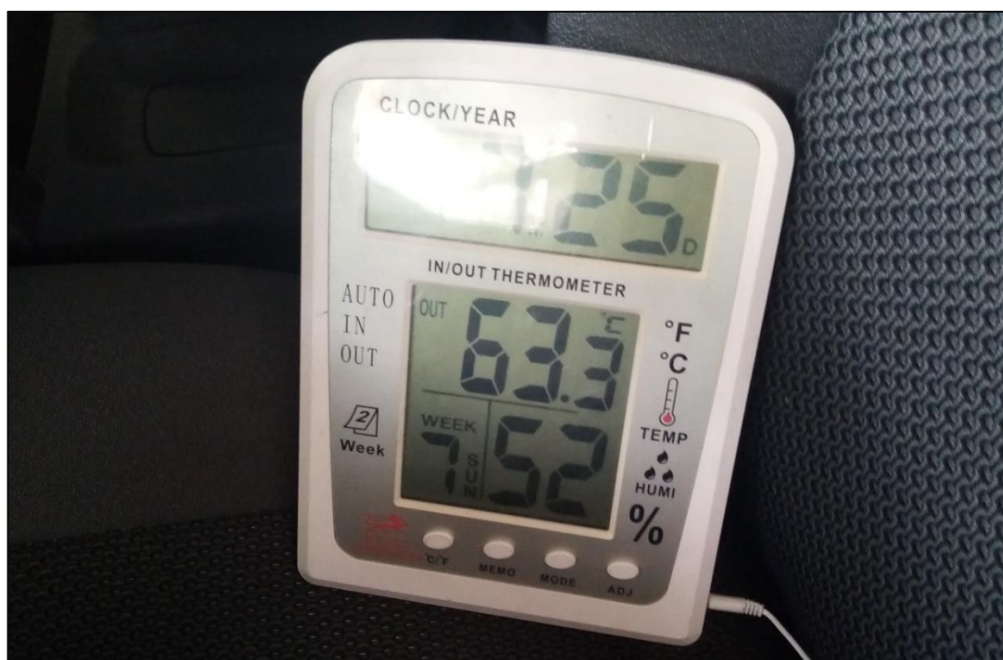
Figura AIII.5 Medición con termómetro digital con sensor la calefacción del sistema es de 63°C.
