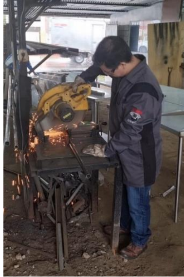
Figura 2.21 Proceso de corte de tubos
