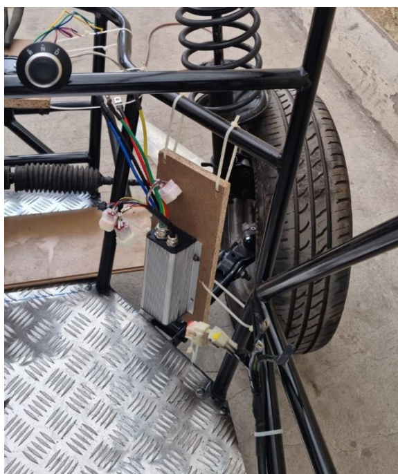
Figura IV.6 Conexión y configuración de los controladores
