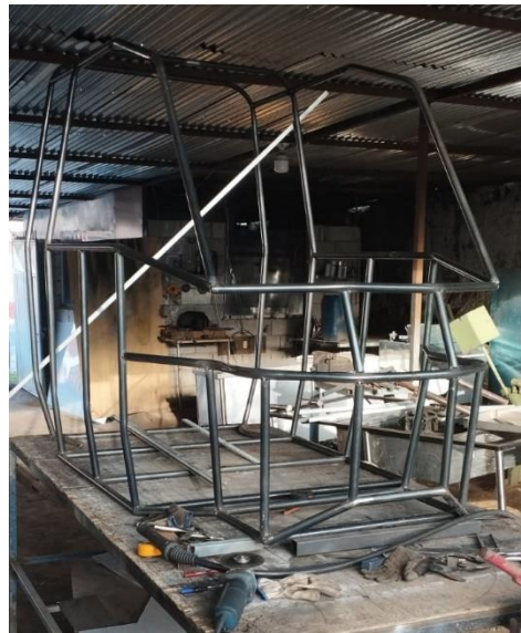
Figura 2.26 Conformación del bastidor
