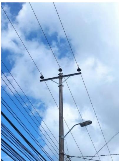
Fig. 2. 4: Red de medio y bajo voltaje
