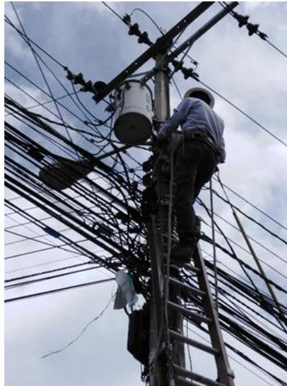
Fig. 2. 8: Instalación de los Analizadores de Red
