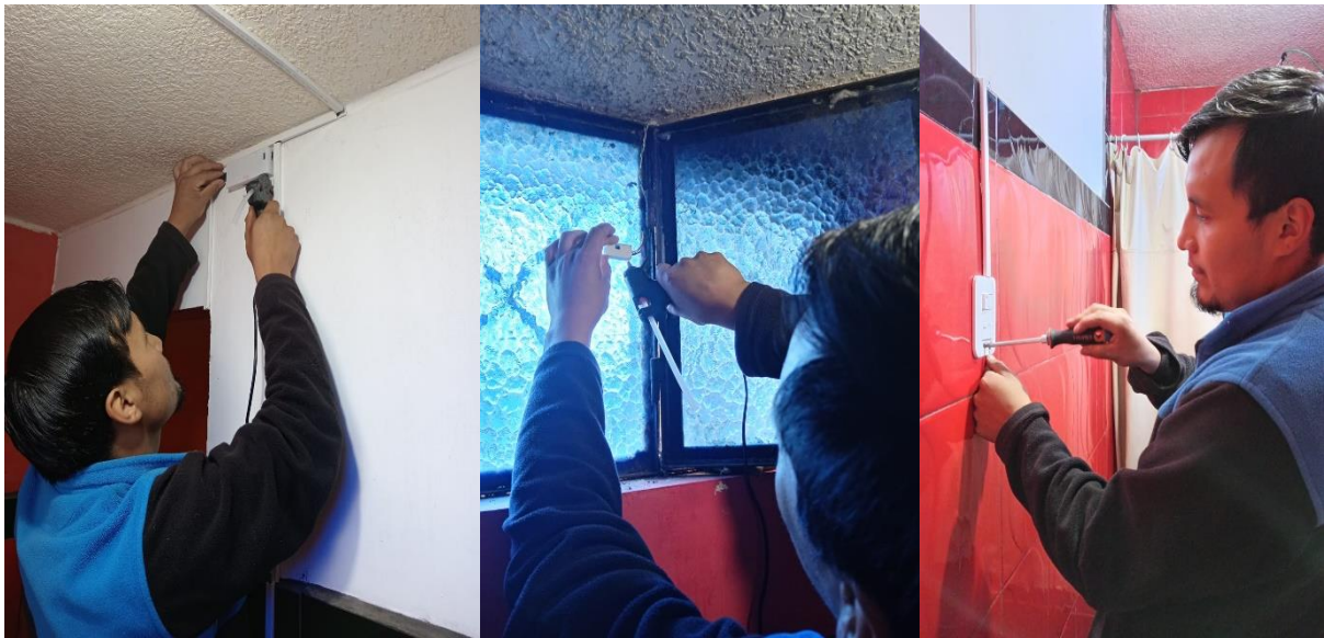
Fig. 76 Instalación de elementos domóticos en el área del baño Fuente: (Autor,2023)
