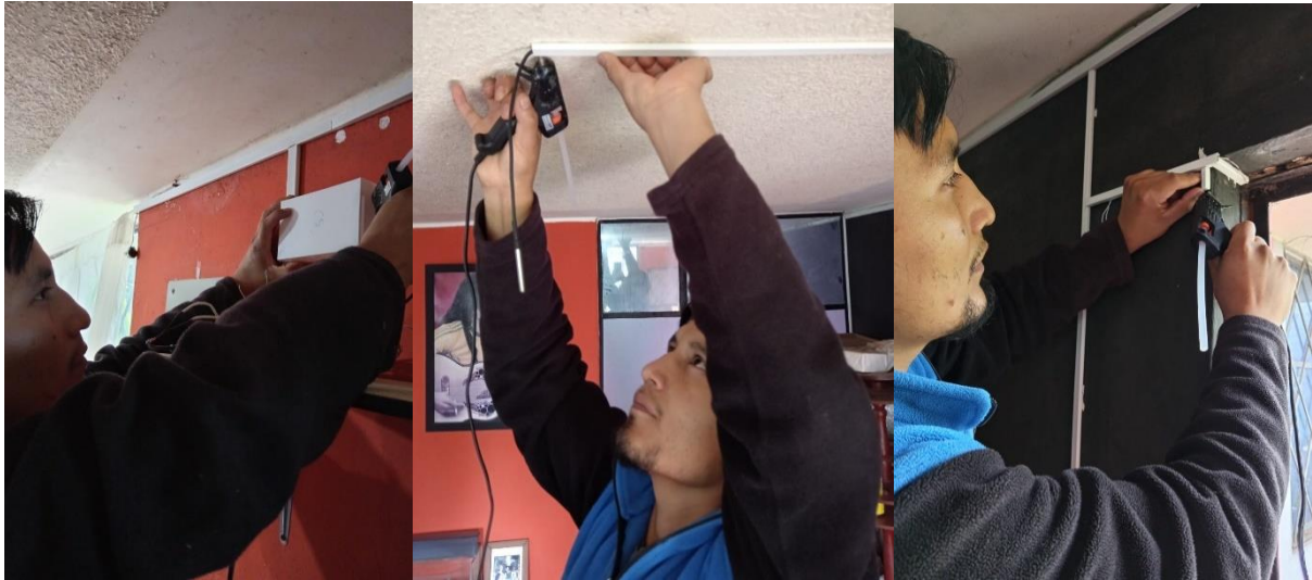
Fig. 70 Instalación de elementos domóticos en el área de la sala. Fuente: (Autor,2023)
