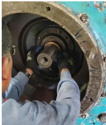
Figura 2.9. Ajuste y colocación de laberinto en el grupo N°2 de la central hidroeléctrica Hidrocarolina
