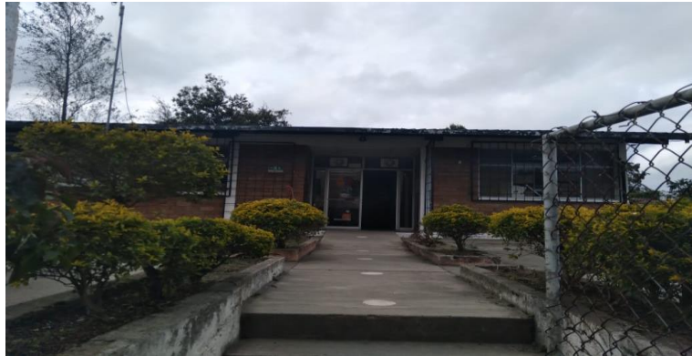
Figura 4. Centro de Salud Quichinche. Fuente propia
