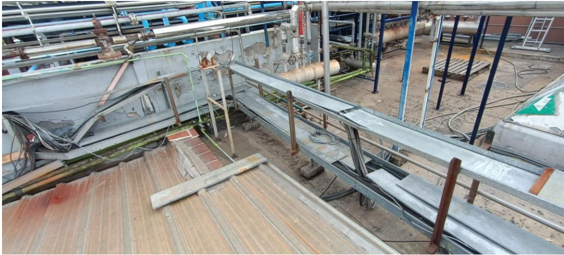
Anexo No. 6 Canaletas
