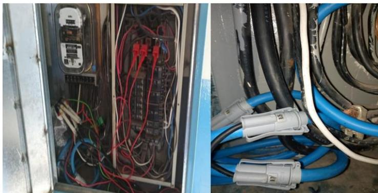
*Nota.* CT colocado con la orientación correcta e instalación completa del equipo de medición.
