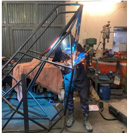
Figura 3.10 Suelda total del bastidor con proceso MAG
