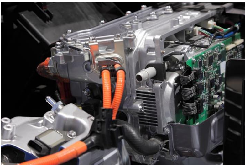
Figura 2.22 Cableado de alta tensión
