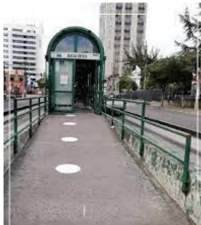
Figura 2.23 Rampa de ingreso
