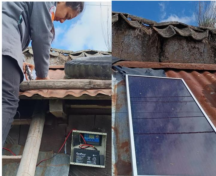
*Figura 4. 1 Instalación del panel solar.*
