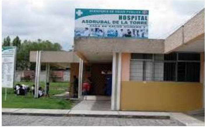
Figura 3. Centro de salud Anidado del Hospital de Cotacachi
