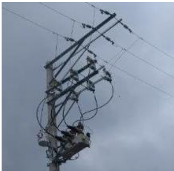
Figura 12. Reconectador trifásico Schneider serie U
