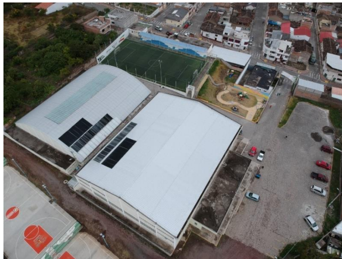
Fig. 14 Vista aérea del Polideportivo "Ciudad de Mira".
