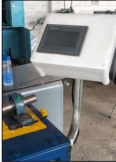
Figura 2.26 Montaje de HMI
