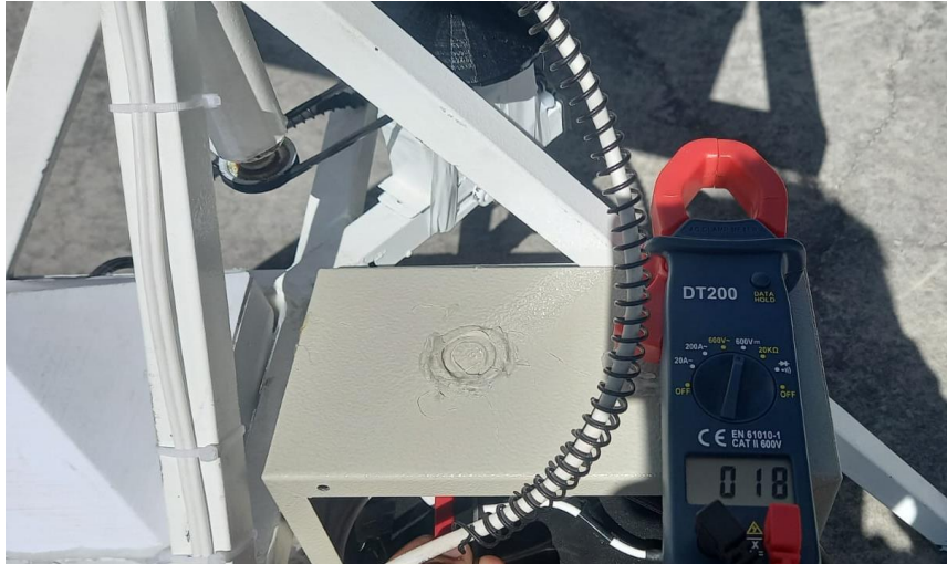
Figura 17. Medición de tensión en paneles fotovoltaicos.
