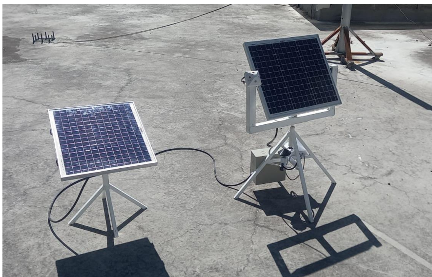
Figura 27. Instalación del sistema de paneles fijo y con seguimiento.
