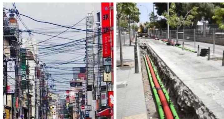
Fig. 6. Impacto visual de redes eléctricas aéreas vs redes subterráneas. [18]
