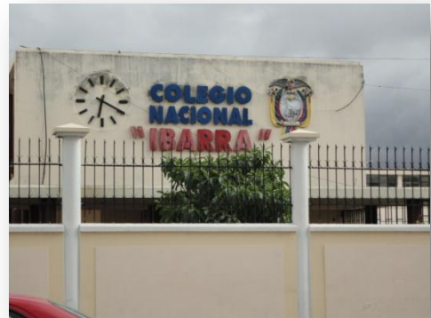
Exteriores de la Institución
