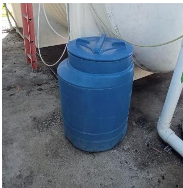
**Fig. 34** Tanque de acumulación de cloro. Elaboración propia.
