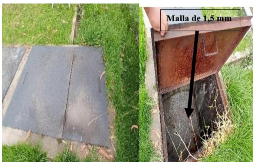
**Fig. 29** Tanque de tamizado. Elaboración propia
