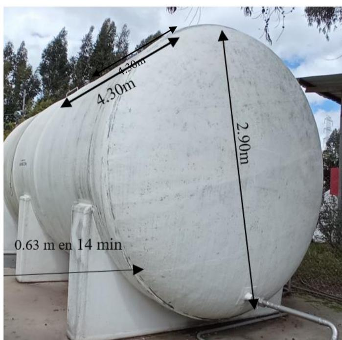
**Fig. 41** Dimensiones de la vista lateral del tanque de aireación
