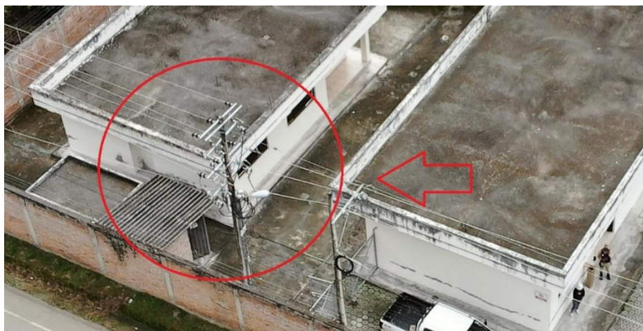
Figura 8 Se muestra el inicio del circuito K3 en la subestación eléctrica La Carolina
