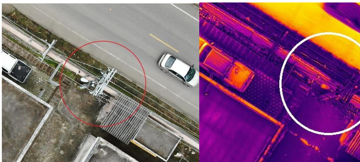
Figura 15 Evaluación en el primer punto de inicio del circuito K3[Foto campo - Foto térmica]
