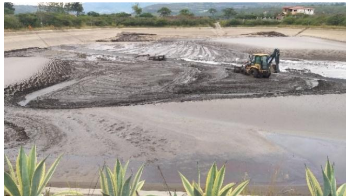
Fig. 16. Reservorio de la C.H. El Ambi en mantenimiento.
