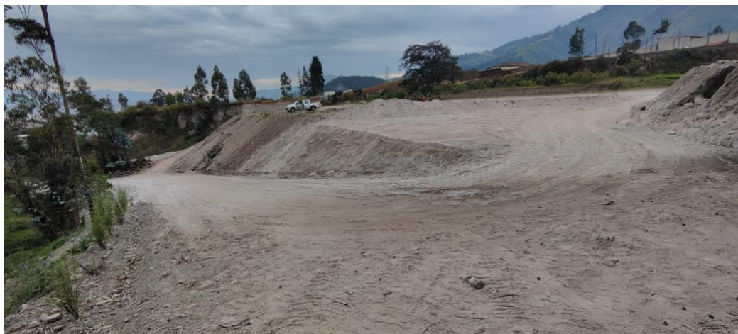
Figura 4 Terreno donde se ubicará el proyecto
