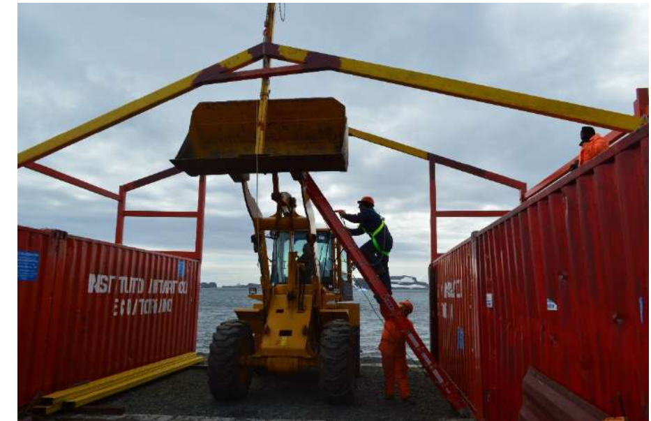
Figura 12. Construcción del área de botes (2013)
